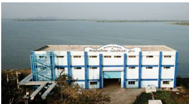
70 MLD WTP (Wyra – Jurala Segment)
